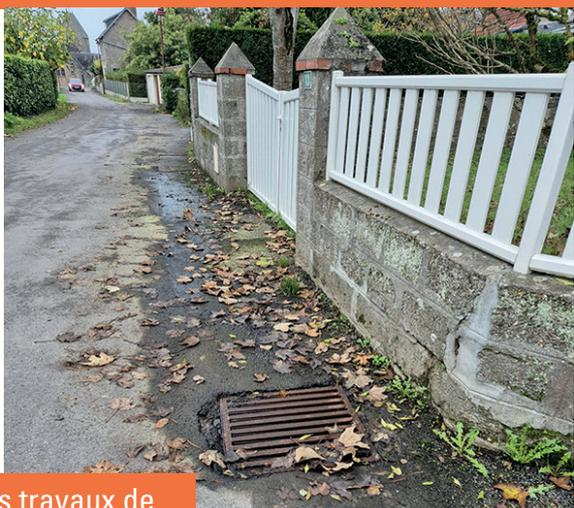
Des travaux de réfection de la canalisation et la pose de grilles avaloirs ont été effectués sur le tronçon aval en 2024.
